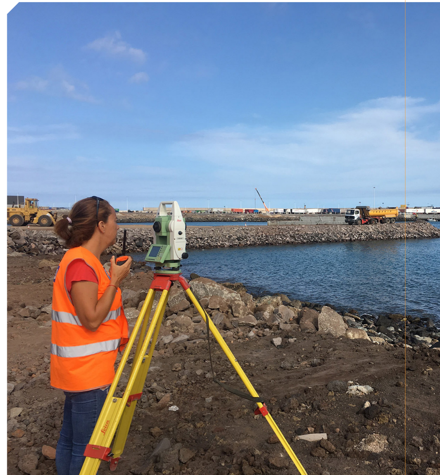
Trabajos de topografía.
